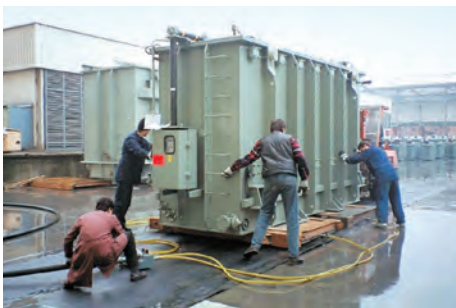
①屋外のコンクリート床面に2枚のマットを連続して敷き、重量物を搬送する
