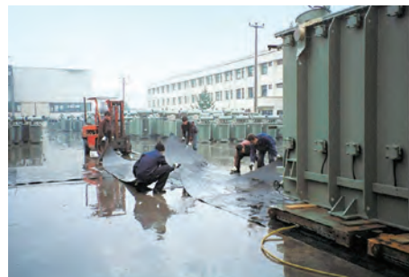
②2枚目のマットまで搬送したら、1枚目のマットを2枚目のマットの前に敷く
