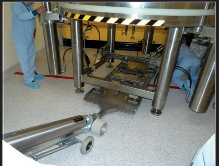
1. ジャッキアップした重量物底面の端部に「搬送ローラー(自在)」を1つ
